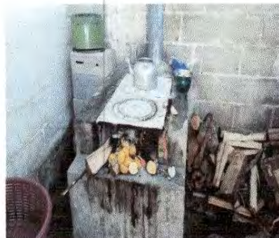
Foto14: 20.2 Sustitución de estufa rural incluye chimenea
