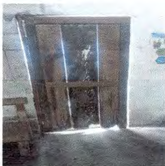
Foto 3:4.3 Sustitución de Puerta
