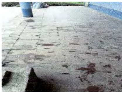
Foto 7: 6.7 Sustitución de piso de granito
