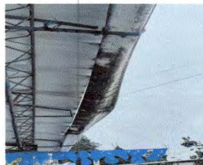
Foto 8: 7.2 Sustitución de canal de PVC
