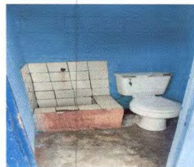
Foto 10: 10.3 Sustitución de inodoro
