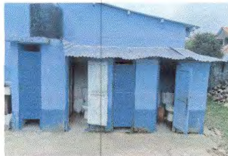
Foto 2: 4.3 Sustitución de Puerta
