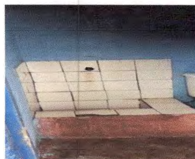
Foto 12: 10.8 Sustitución de mingitorio
