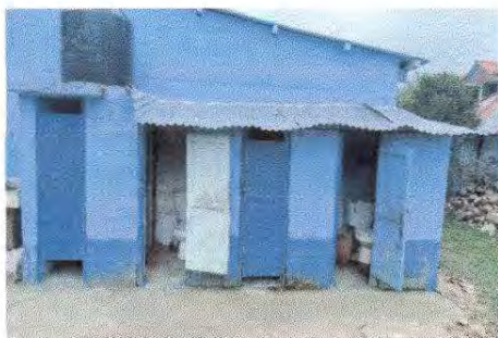
Foto1: 2.2 Sustitución de Estructura de Madera por Metal
