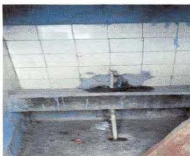
Foto 11: 10.5 Sustitución de lavamanos
