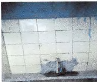
Foto 13: 13.1 Sustitución de azulejo
