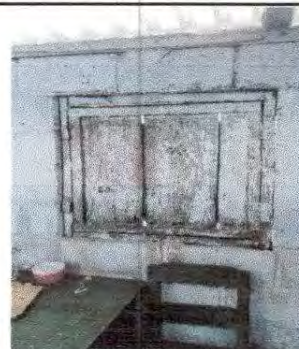
Foto 4: 5.3 Sustitución de ventana
